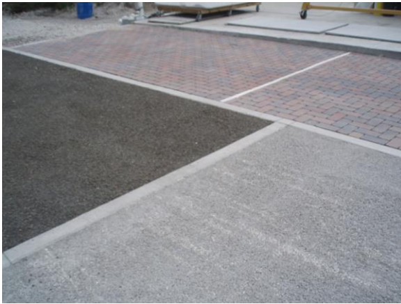
Figure 5.1.i – Porous Pavements
